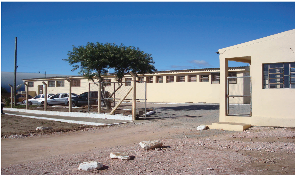
Figura 2 - Vista externa do PEC
