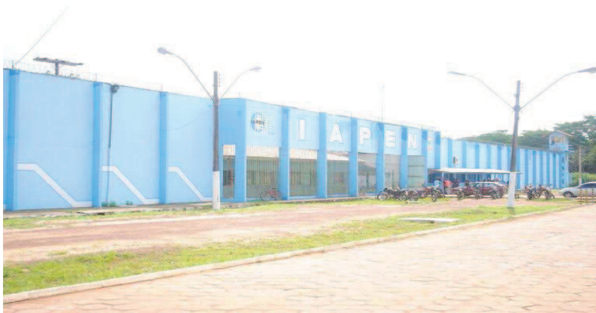
Figura 1 - Vista externa do IAPEN
