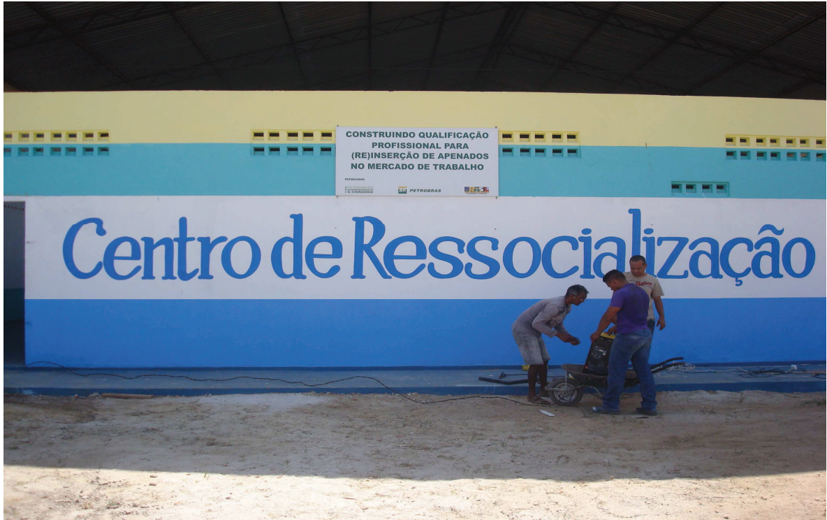
Figura 4 - Fachada do centro de ressocialização Foto do Autor
